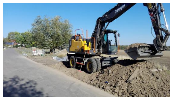
Baustelle am Parkplatzstandort in Plötzkau
